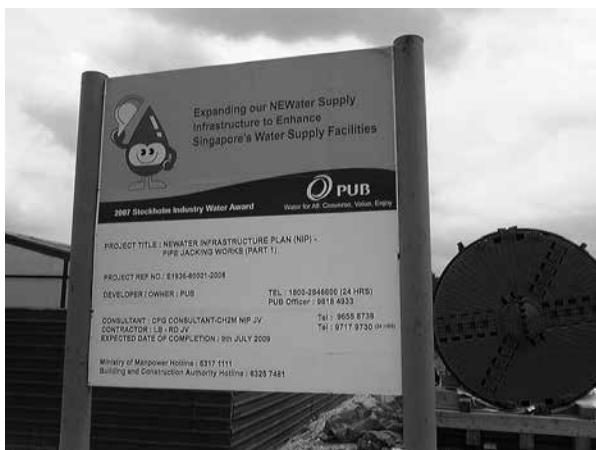
写真一 海外工事で活用される日本の掘進機
