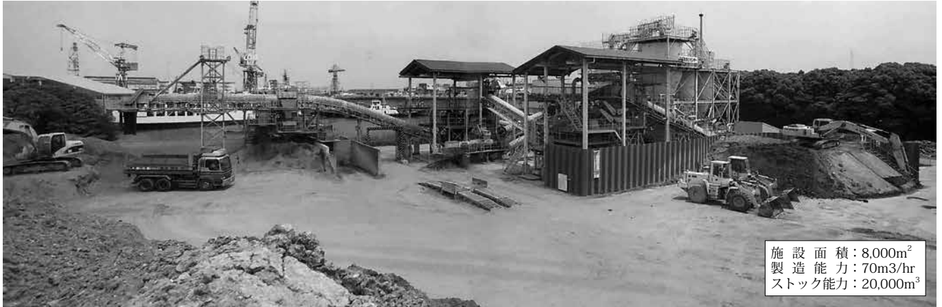
写真-1 改良土プラントの全景
