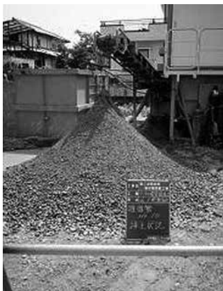
写真-2 マスターRからの土砂搬出状況
