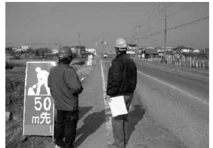
写真-1 KY実施状況（現地踏査）
