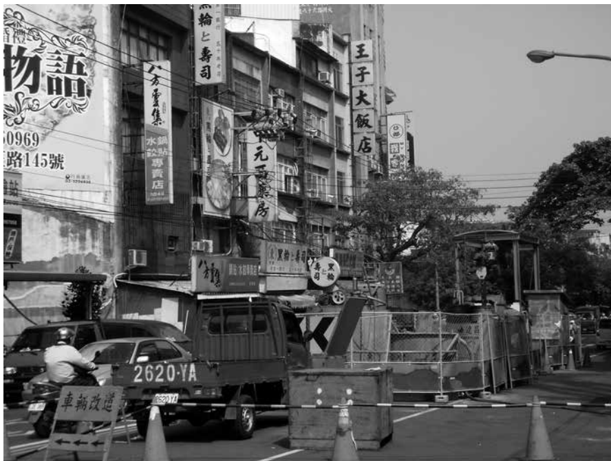
写真-1 台湾での現場風景
