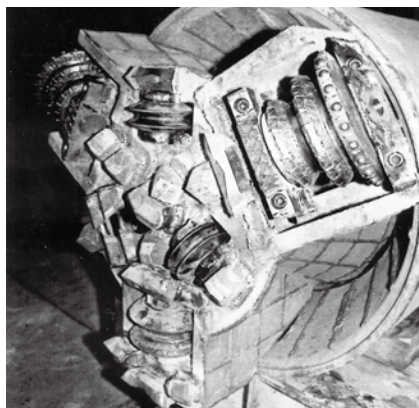
写真-1 岩盤対応型掘進機1号機の面板
