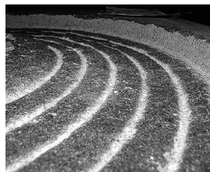
写真-8 ディスクカッタでの掘削面
