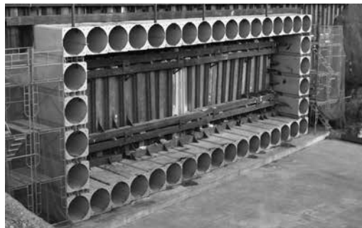
写真-3 SFT工法・ルーフ配置
