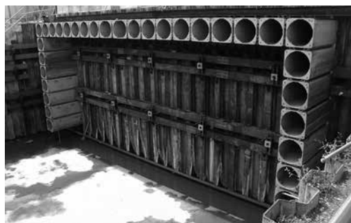
写真-2 R&C工法・ルーフ配置
