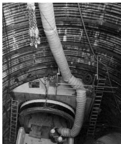
写真-1 立坑下アーチカルバート底部設置
