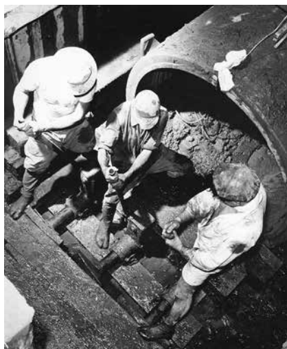
写真-1 手押しシップジャッキを用いた初期の押管作業（昭和27年頃）
