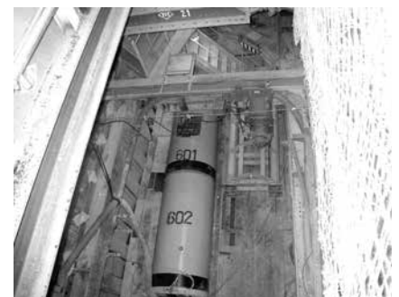
写真-1 2管推進用発進立坑・推進中
