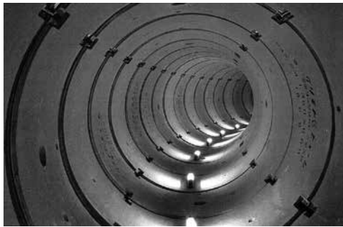
写真-2 急曲線施工事例（目地開口抑制付）
