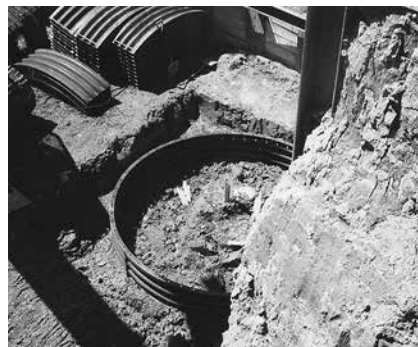
写真-1 ライナープレート立坑
