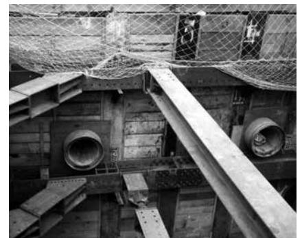
写真-2 親杭横矢板立坑
