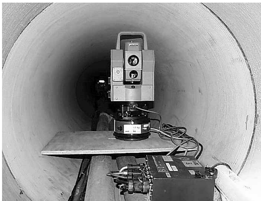
写真-1 管内設置状況
