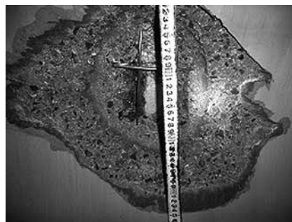
写真-1 礫による管破壊状況
