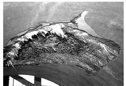
写真-4 一点荷重試験による破壊（穿孔）状況（白く見えているのがガラス繊維）
