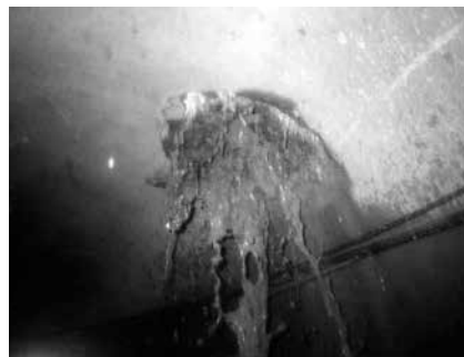
写真-1 玉石転動による推進管の破損
