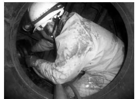
写真-3 ビット交換作業状況
