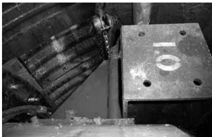
写真-2 バッキング金物取付状況
