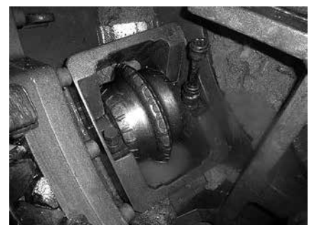
写真-5 外周部交換状況
