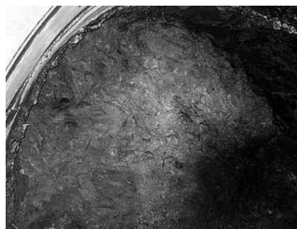
写真-1 発進坑口部土質
