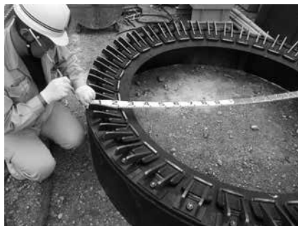
写真-1 坑口リング(フラップ板付)φ1500mm
