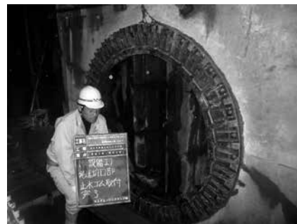
写真-2 坑口リング(フラップ板付)設置状況
