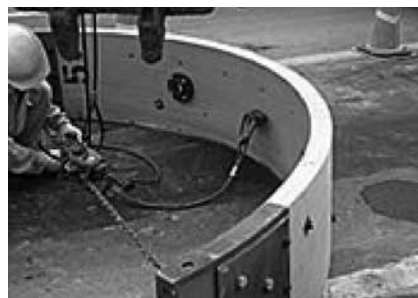
写真-3 ライナープレート用FFU部材
