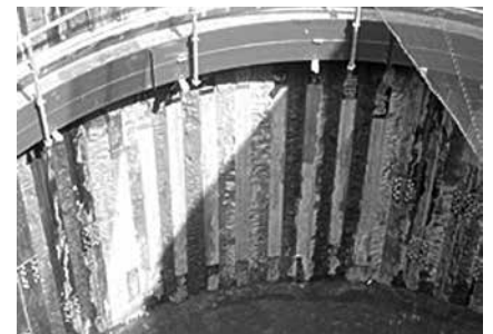
写真-2 FFU部材施工状況
