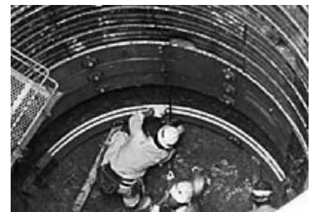
写真-4 FFU部材施工状況
