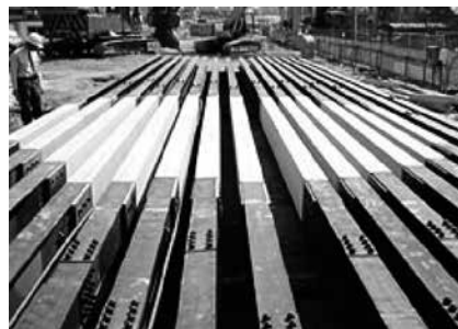
写真-1 柱列式連続壁用FFU部材
