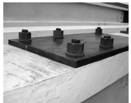
写真-4 ブラケット取付用ボルト
