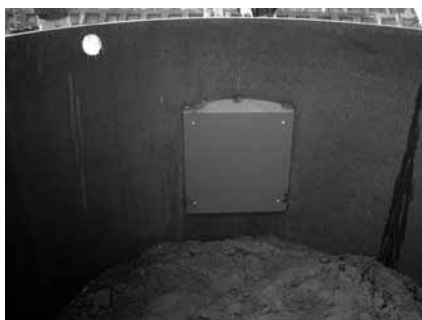
写真-4 保護鋼板設置状況
