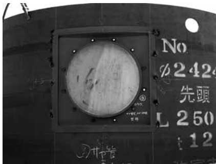
写真-3 土留め壁設置状況
