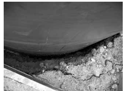
写真-6 回転圧入時の空隙
