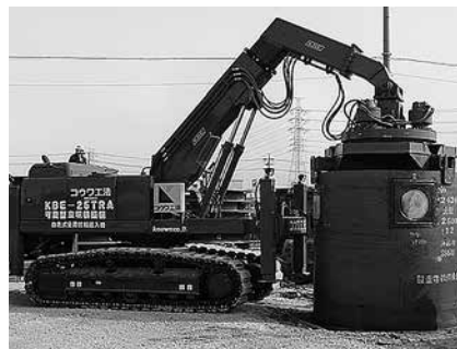
写真-5 コウワ工法による回転圧入
