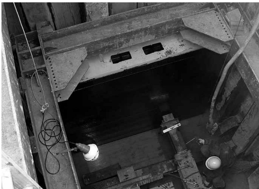
写真-5 バックロック使用状況①
