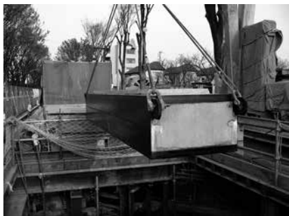
写真-3 バックロック吊り下し状況
