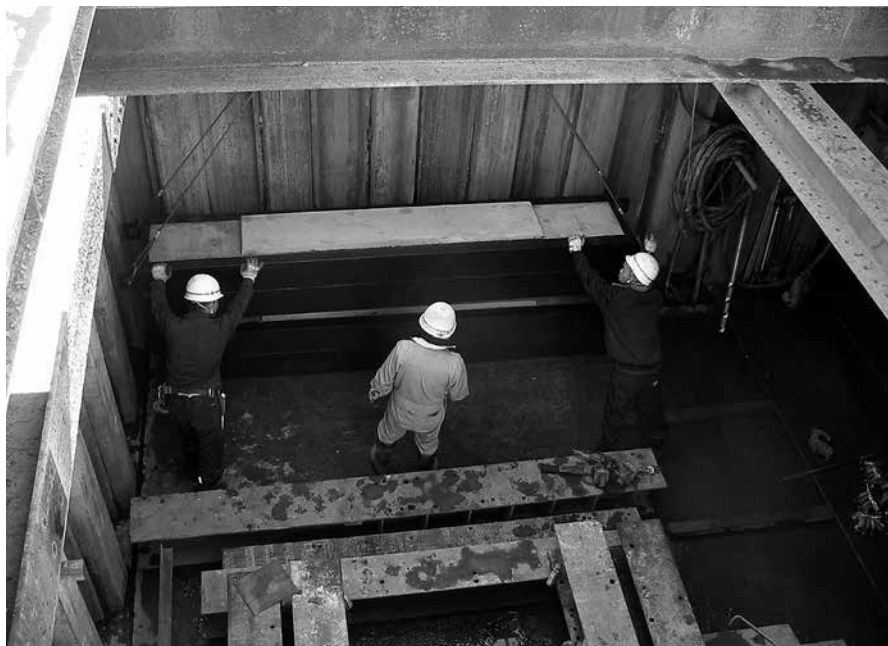
写真-4 現場組立て式の設置状況
