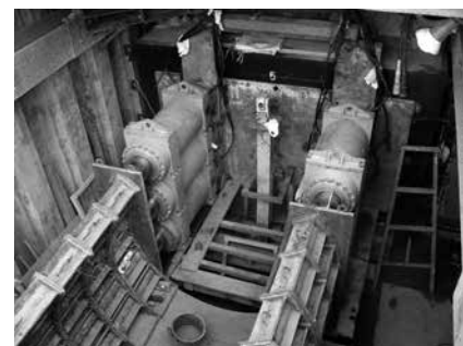
写真-6 バックロック使用状況②
