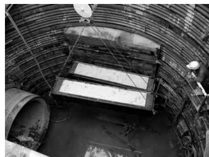
写真-2 バックロック工法の解体と移設
