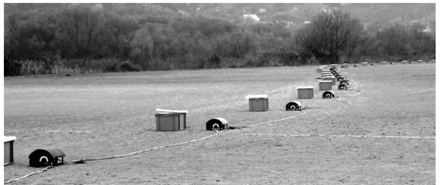
写真-5 CCDカメラセンサーによる地上測量 結合トラバース
