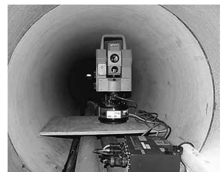
写真-1 設置状況
