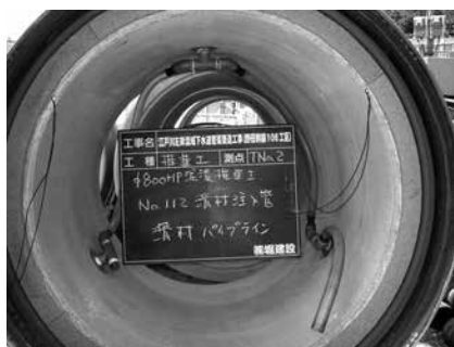
写真-3 滑材注入管
