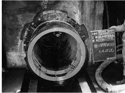
写真-4 開口調整装置設置状況
