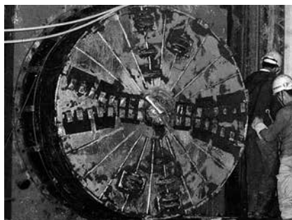
写真-6 \phi 1650 到達状況
