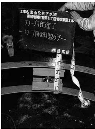
写真-3 組立状況
