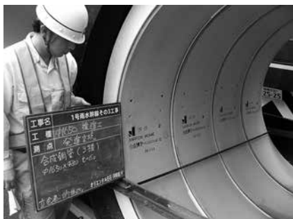
写真-2 合成鋼管の検収状況
