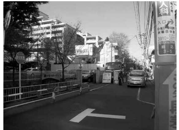
写真-1 発進立坑状況
