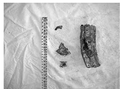
写真-4 SJS継手部 (SUS) 破碎状況
