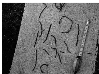
写真-8 排出された鉄筋
