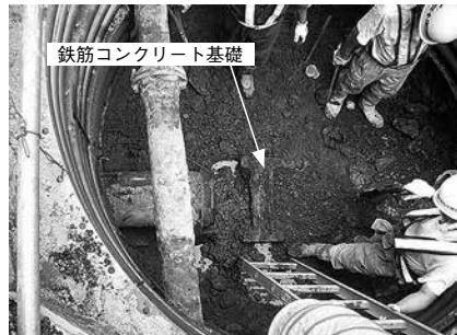
写真-3 発進立坑築造
