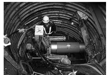
写真-6 推進状況
