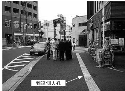
写真-1 工事場所全景と事前打合せ風景
