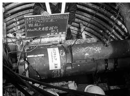
写真-5 先導管据付
