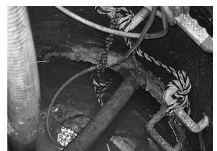
写真-12 裏込め状況
