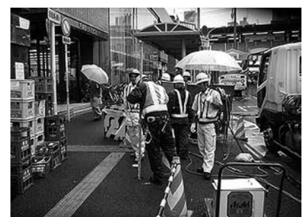
写真-9 ガス管沈下測定
