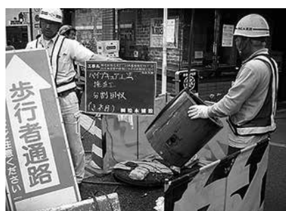
写真-11 先導管分割回収
