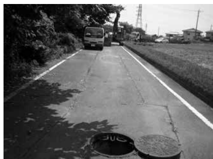
写真-3 現場状況（立坑構築時）
