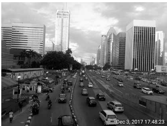
写真-1 インドネシア初の地下鉄工事が進むジャカルタ市内スディルマン通り
