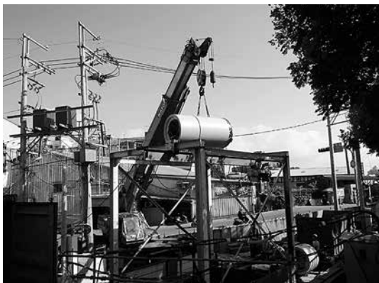
写真-2 掘進機投入
