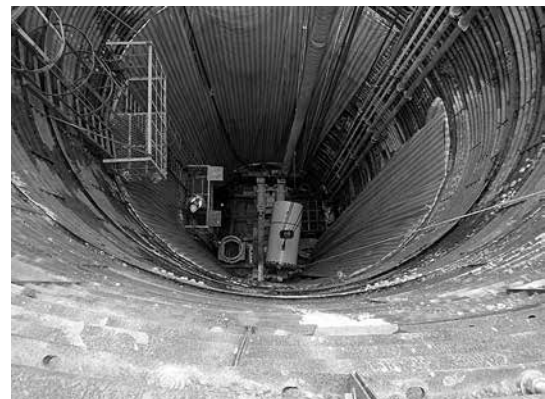
写真-3 掘進機投入
