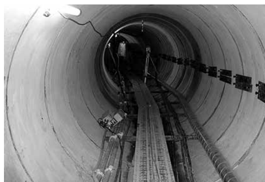
写真-1 管内状況
