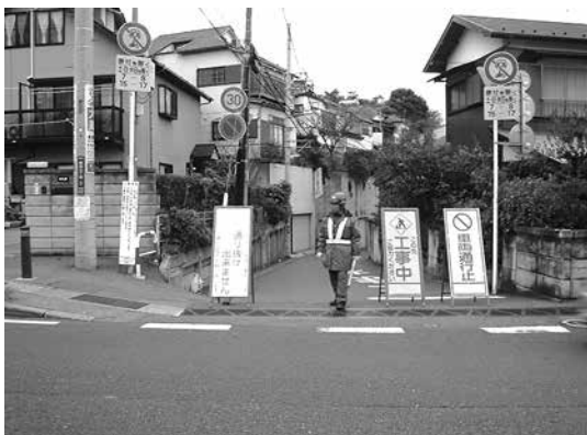
写真-1 既設到達マンホール
