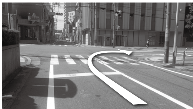
写真-2 R=30m 曲線部交差点状況
