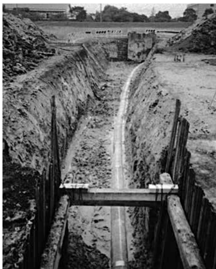
写真-1 曲線試行推進（推進後上部の土を撤去）
