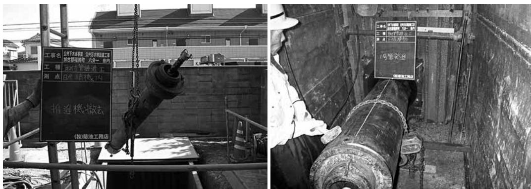
写真-2 左画像のインパクトモール推進機を鋼管の中に入れてテール部分で鋼管を押し出す
