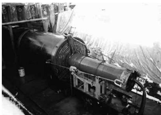
写真-1 推進機のヘッド部分で鋼管を押して圧入する
