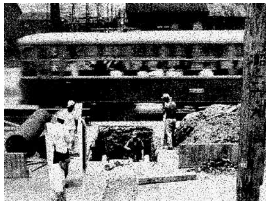
写真-2 人力作業風景（昭和26（1951）年 市電軌道横断工事）
