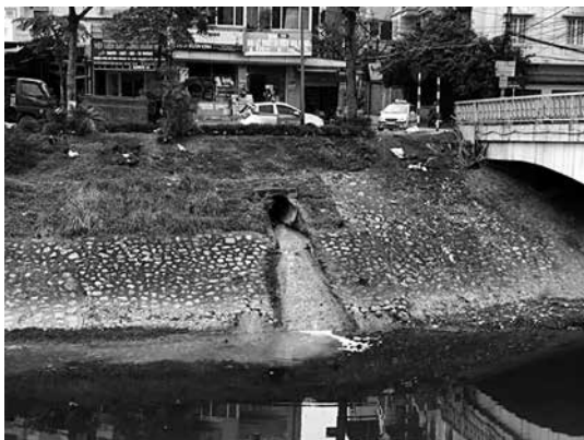
写真-2 未処理の汚水が流入する河川（ハノイ市内）
