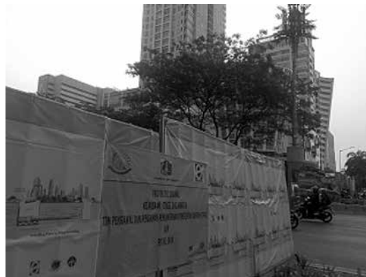
写真-3 手前が推進工事立坑現場(ジャカルタ中心部)
