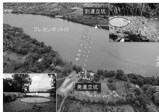
写真-3 カンポットでの推進工箇所の様子
