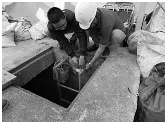
写真-3 腐食調査状況@バイマウ処理場
