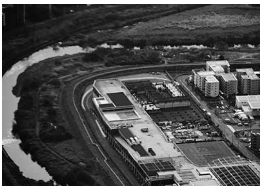
写真-2 新羽雨水調整池
