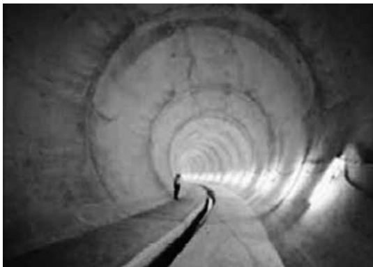
写真-1 小机千若雨水幹線内状況
