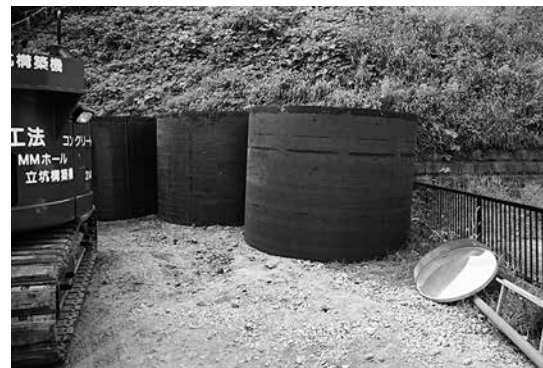
写真-2 施工現場の鋼製ケーシング仮置場状況
