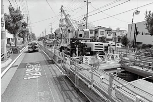
写真-1 立坑掘削時の作業ヤードの様子
