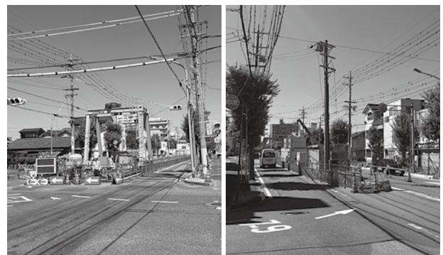
写真-3 特別製作した門型クレーン
