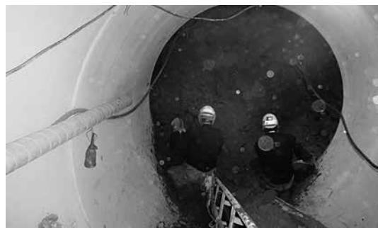
写真-1 刃口式推進（切羽掘削）
