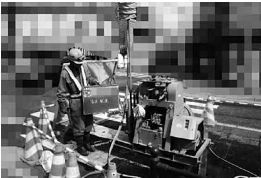
写真-1 二重管ストレーナ工法の施工
