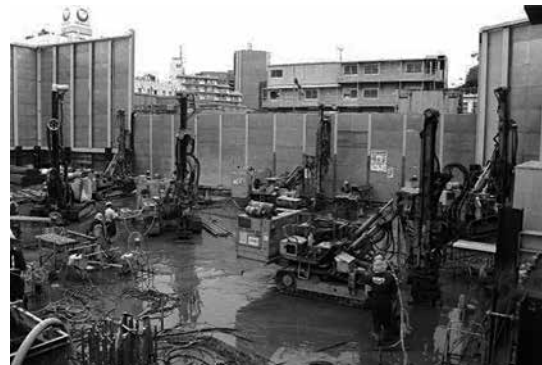
写真-2 ダブルパッカー工法の施工
